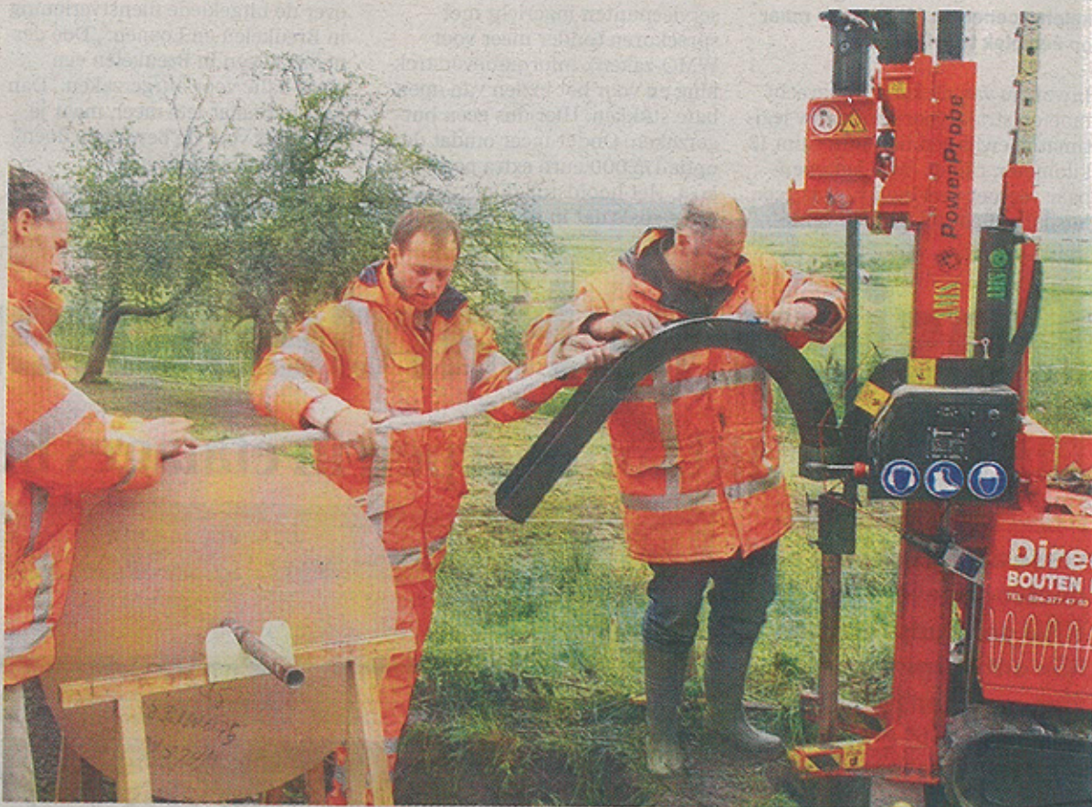
In de Stammerdijk worden geobeads aangebracht. FOTO PR
